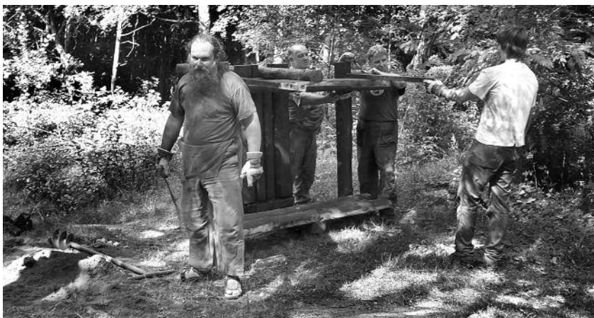
Stavba turistického odpočívadla u Skautské studánky nad Lidovými sady
