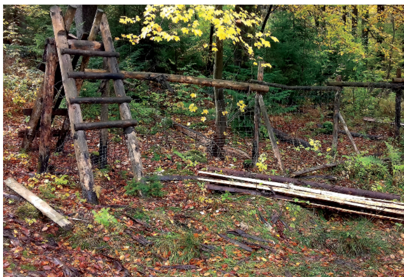
Oprava oplocenky v biocentru Zvonice u Kořenova Foto Michal Vinař
