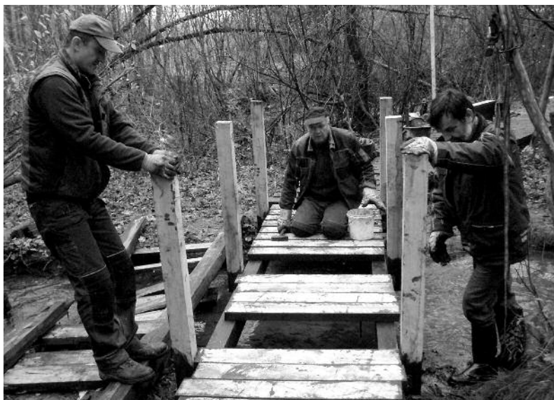
Montáž můstku přes Luční potok na naučné stezce kolem Veseckého rybníka
