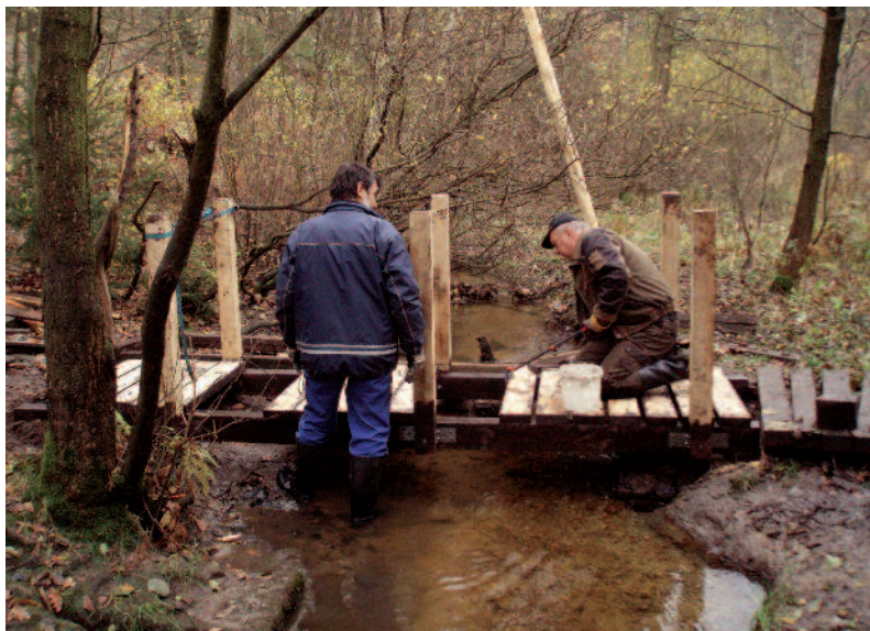
Montáž nové lávky přes Luční potok na naučné stezce u Veseckého rybníka
