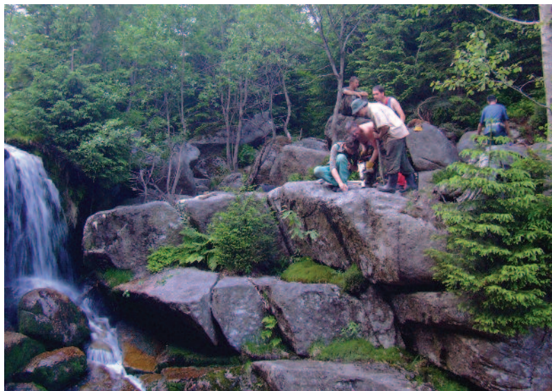
Rekonstrukce zábradlí vyhlídky u vodopádu Jedlové
