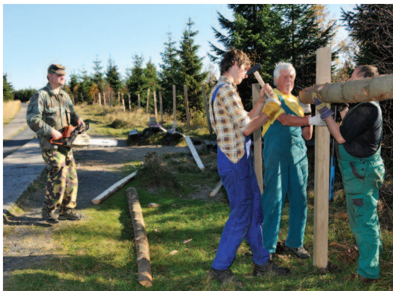
Příprava materiálu a stavba oplocenky v PR Na Čihadle
