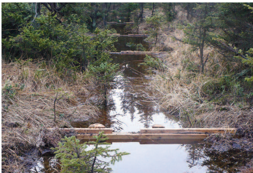
Hrazení drenážních příkopů v rašeliništi PR Nová louka
