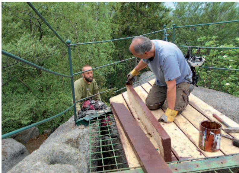
Rekonstrukce vyhlídky na Martinské stěně
