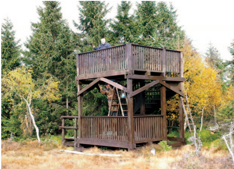
Oprava vyhlídkové věže v přírodní rezervaci Na Čihadle Foto Milan Šteinfest
