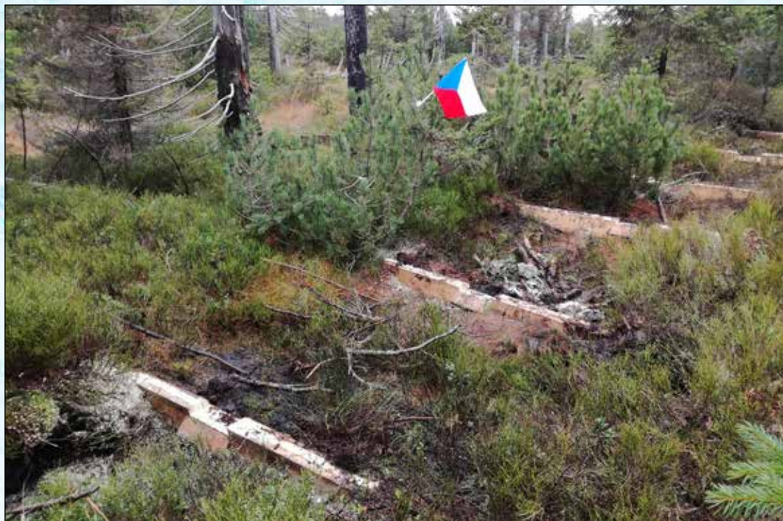
Hrazení melioračních příkopů na rašeliništi Vánoční louka. Pracovali jsme i ve státní svátek.
